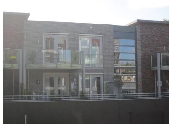
Beperkte vrije ruimte voor werkzaamheden aan de gevel
