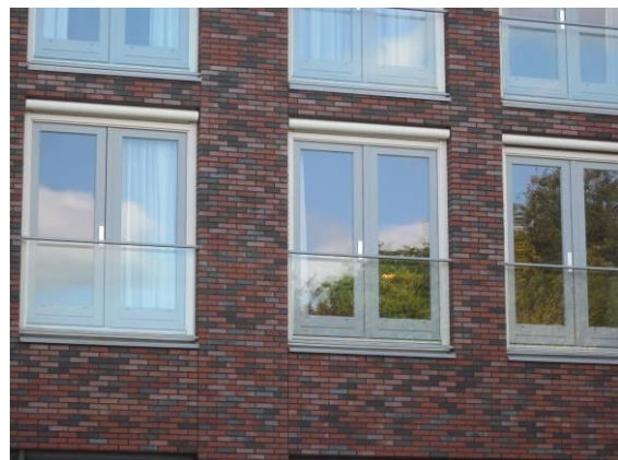
Ramen in de gevel welke naar binnen openen
