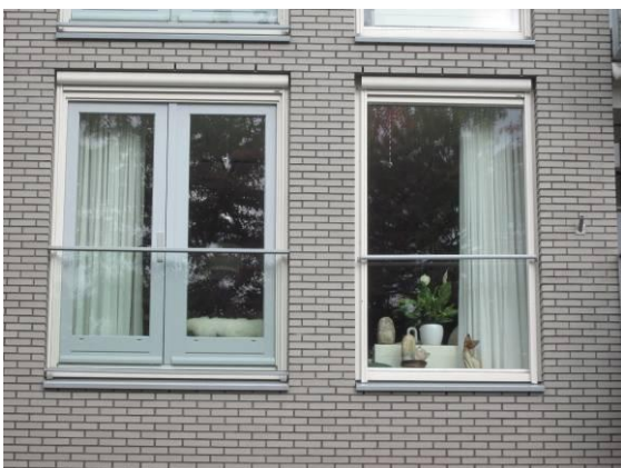
Ramen in de gevel welke geopend kunnen worden
