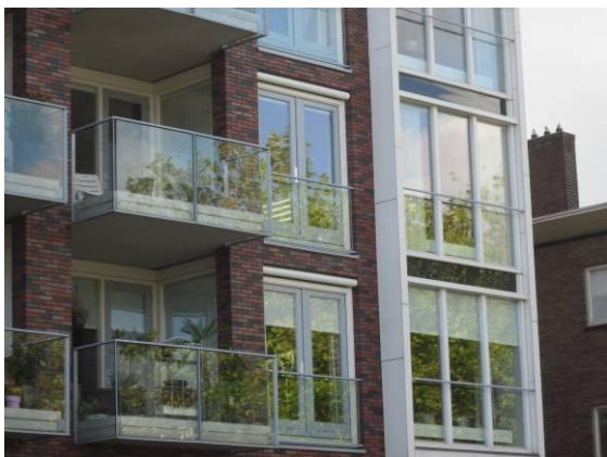
Balkon voorzien van een glazen afscheiding
