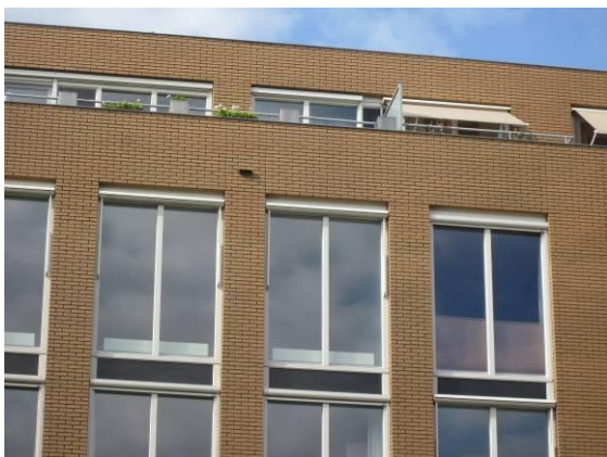
Balkon voorzien van een borstwering
