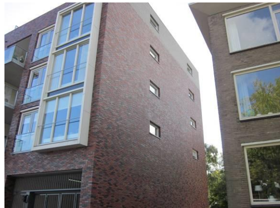
Reinigingswerkzaamheden worden uitgevoerd met behulp van een hoogwerker
