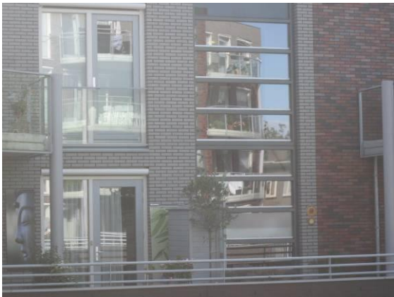
Glazen gevel ter plaatse van het trappenhuis
