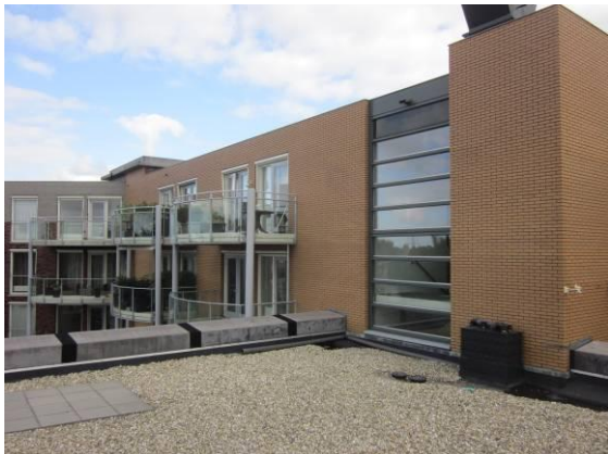
Een deel van de gevel bevindt zich boven een dakvlak
