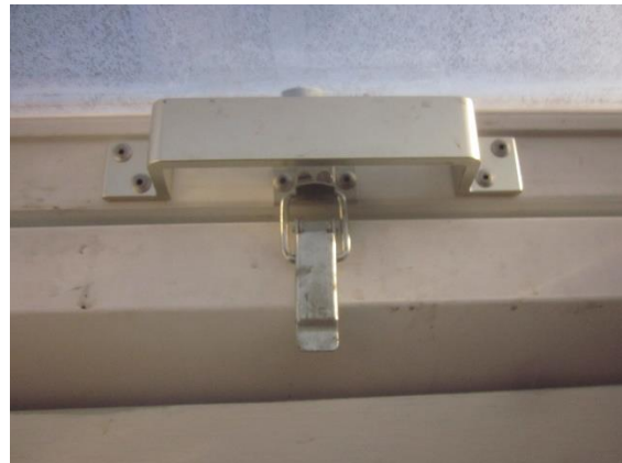
Er ontbreekt een slot op het dakluik
