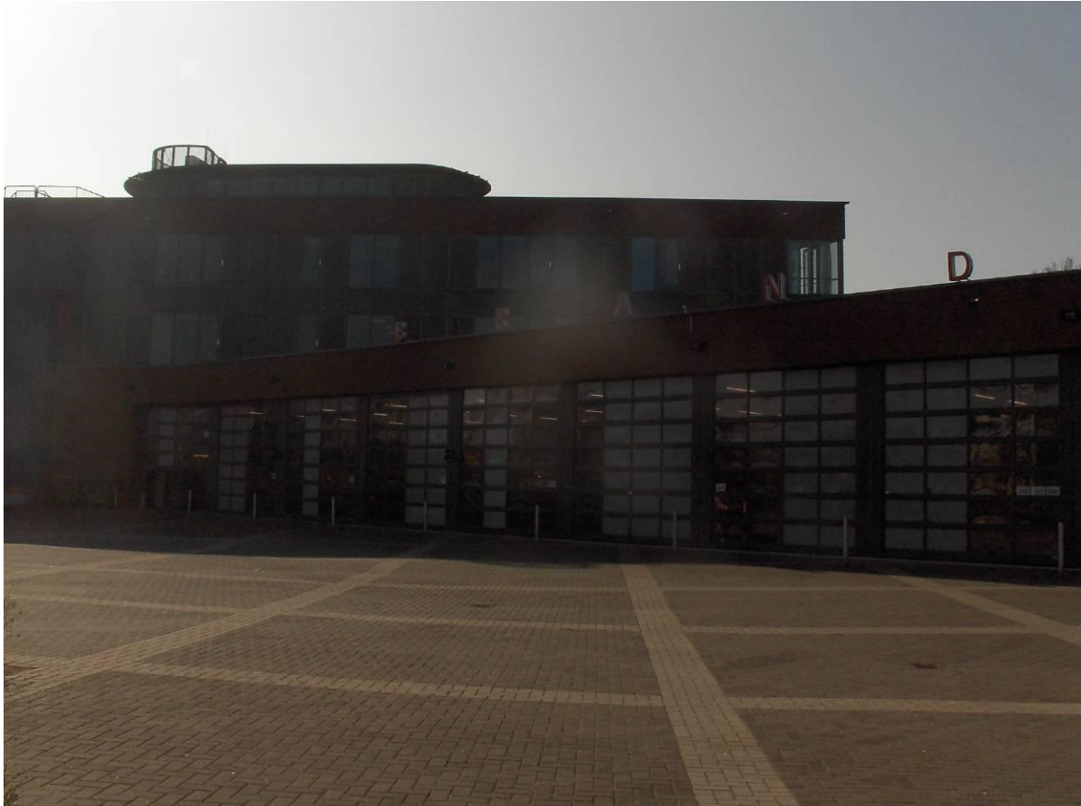
Foto: Brandweerkazerne te Den Haag
