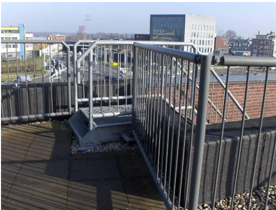
Veilige toetreding tot het met hekwerk omringde dakgedeelte via een noodtrap
