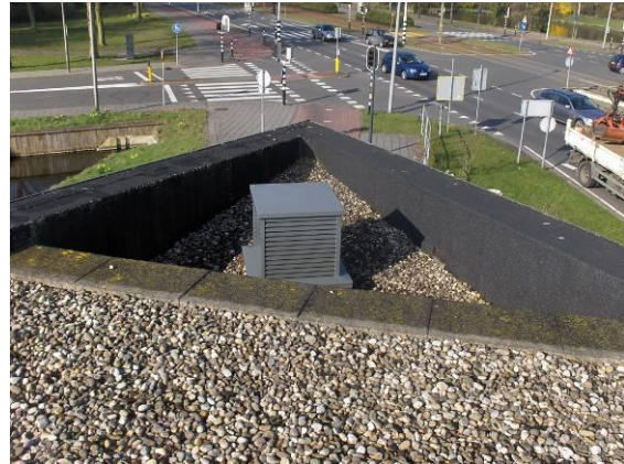
Fysieke belasting bij het betreden en verlaten van het lager gelegen dakdeel
