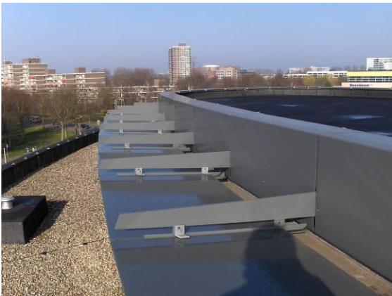
Glazen luifel niet betreden. Reiniging vanaf naastgelegen dakvlak
