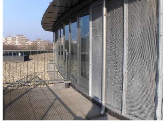
Veilige toetreding tot het met hekwerk omringde dakgedeelte via een deur
