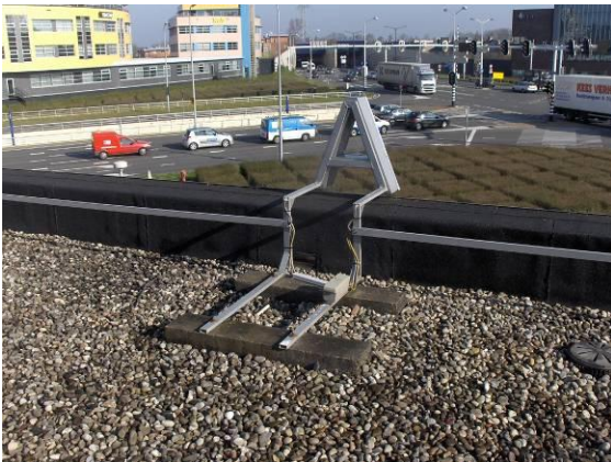
Reclamebord binnen 2 meter van de dakrand
