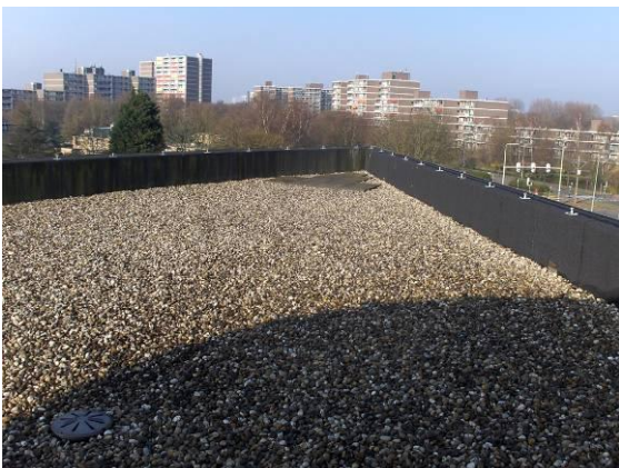
Een 50 cm hoge en 35 cm brede borstwering rondom het dakvlak voorzien van bliksembeveiliging
