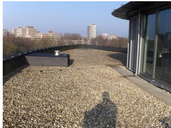
Hoger gelegen dakdeel op het dakvlak
